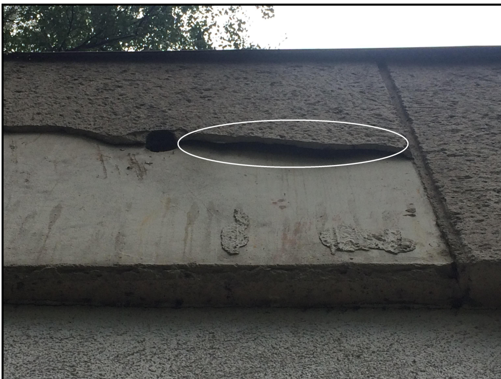
Obr. 2: Dutina (elipsa) mezi omítkou a fasádou na východní straně komplexu – potenciální stanoviště netopýrů
