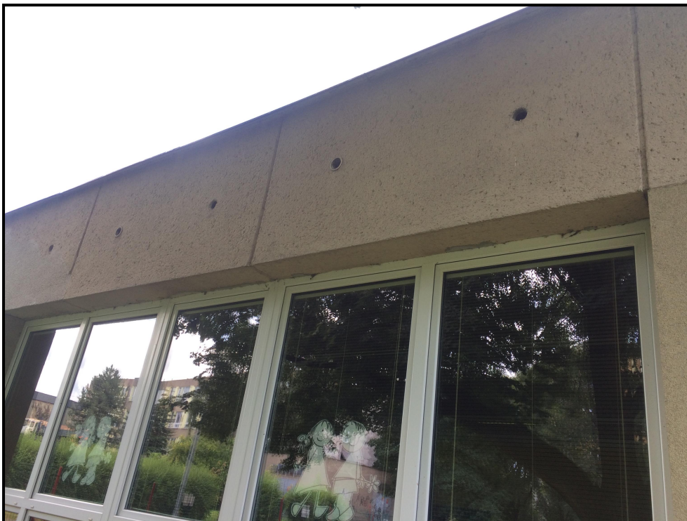
Obr. 1: Příklad podstřešních ventilačních otvorů bez mřížek (v otvoru vpravo bylo prokázáno hnízdění rorýsa obecného) a větších okenních tabulí nedostatečně zajištěných proti nárazům ptáků na jižní straně komplexu
